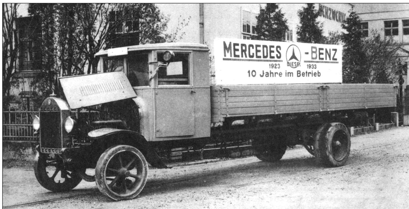
Erster Benz-Diesel-Lkw: Typ 5 K 3 mit Rohöl-Vorkammer-Motor nach 10 Jahren Betriebsdauer 1933
