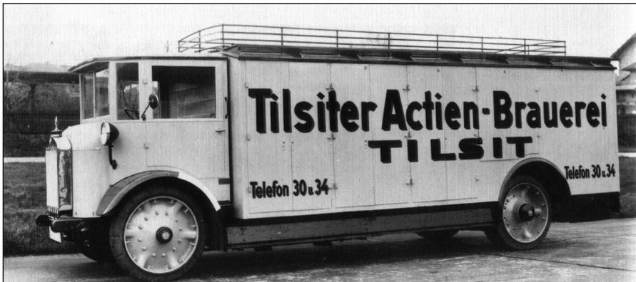
Dreitonner Typ L 3 mit 70-PS-Sechszylindermotoren 1927
